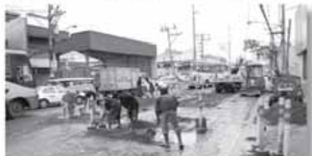
Inaayos ang kalsada sa paanan ng Tullahan Bridge
