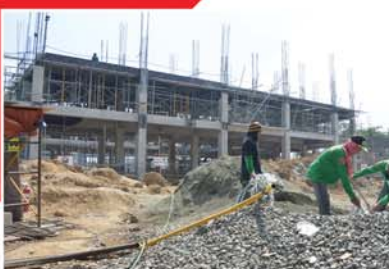
Ang ongoing construction ng Valenzuela City School of Mathematics and Science sa A. Pablo St., Brgy. Malinta. Nakatakdang ang pagbubukas nito sa darating na Hulyo ngayong taon.
